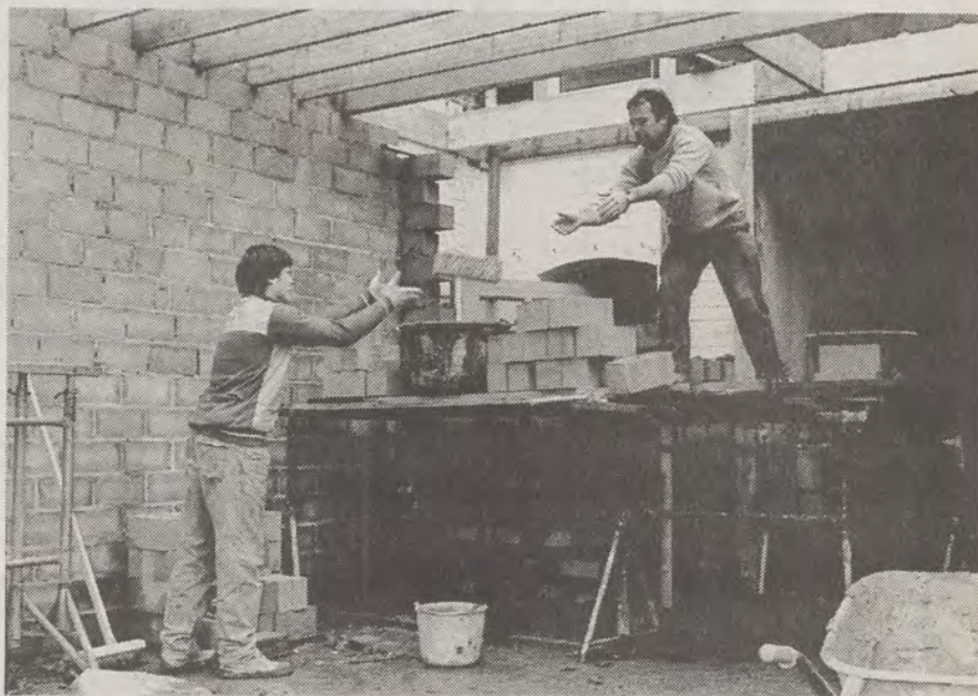
Kristian gooit Frank bakstenen toe, in het verlengde van de nieuwe hal moet een toiletruimte opgetrokken worden.
