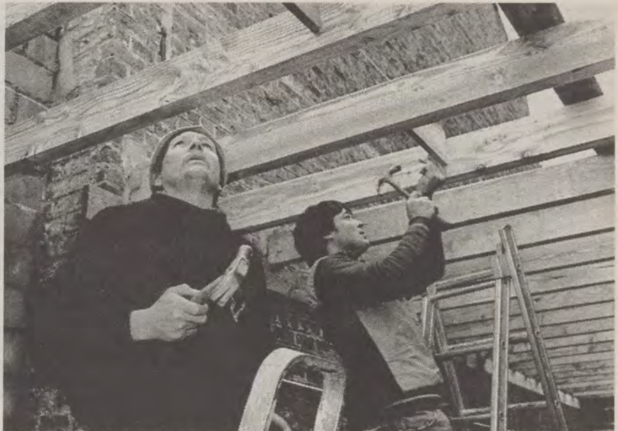
Meestergast Mark en Kristian bij de konstruktie van het dak boven de nieuwe garage.
