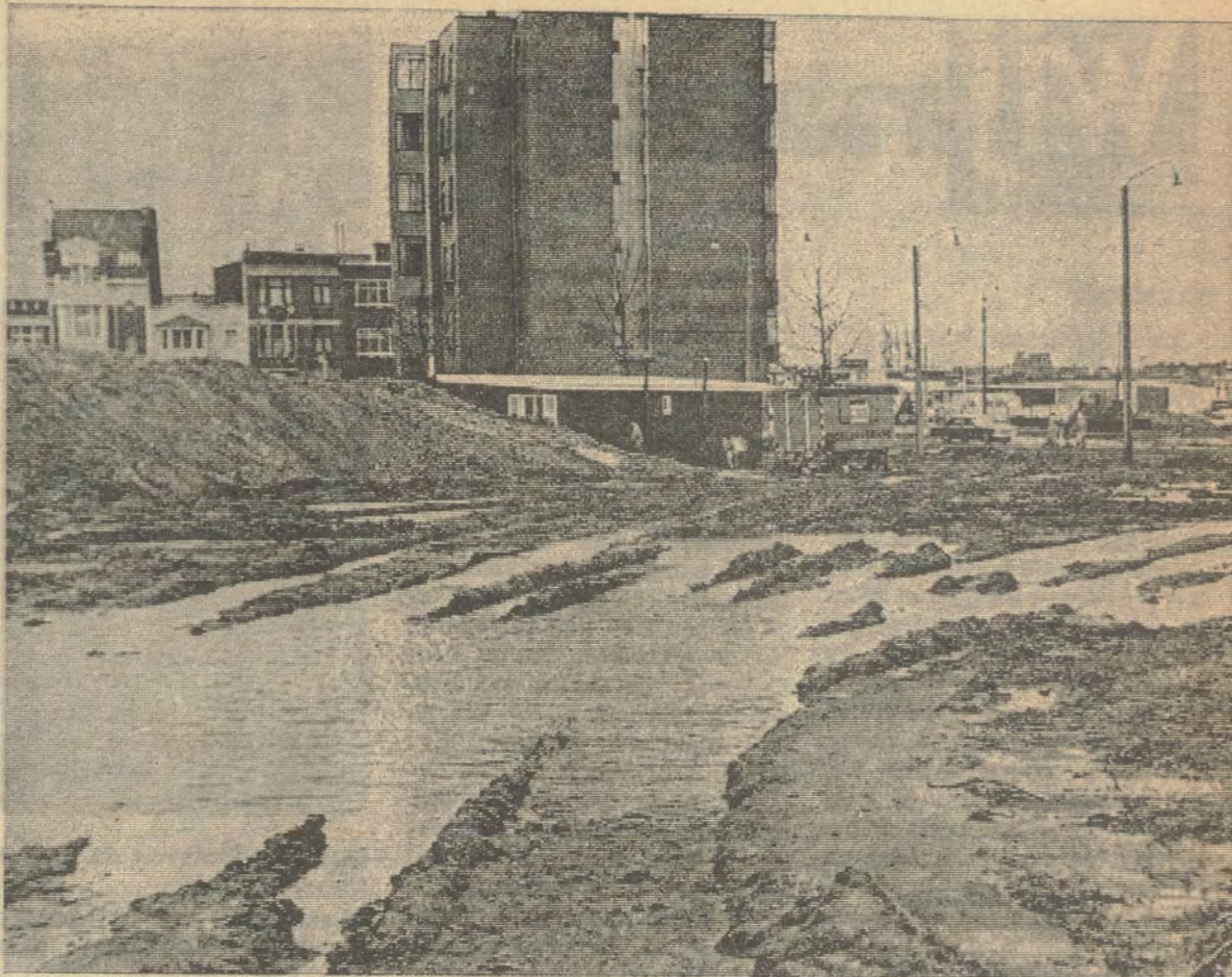
Voorlopig nog een modderpoel: de bouwwerf van de E-3 ertgens in de Antwerpse agglomeratie.
