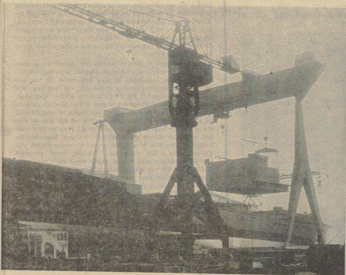
De stuurhut en de lokalen eronder van de «Montaigle», nieuw schip van de CMB, werden vooraf gemonteerd en volledig uitgerust. Ze werden te Hoboken als een geheel door een kraan op het schip neergelaten en er op gemonteerd. Het ganse bovendeck werd op die wijze op de romp aangebracht. Totaal gewicht: 295 ton.
