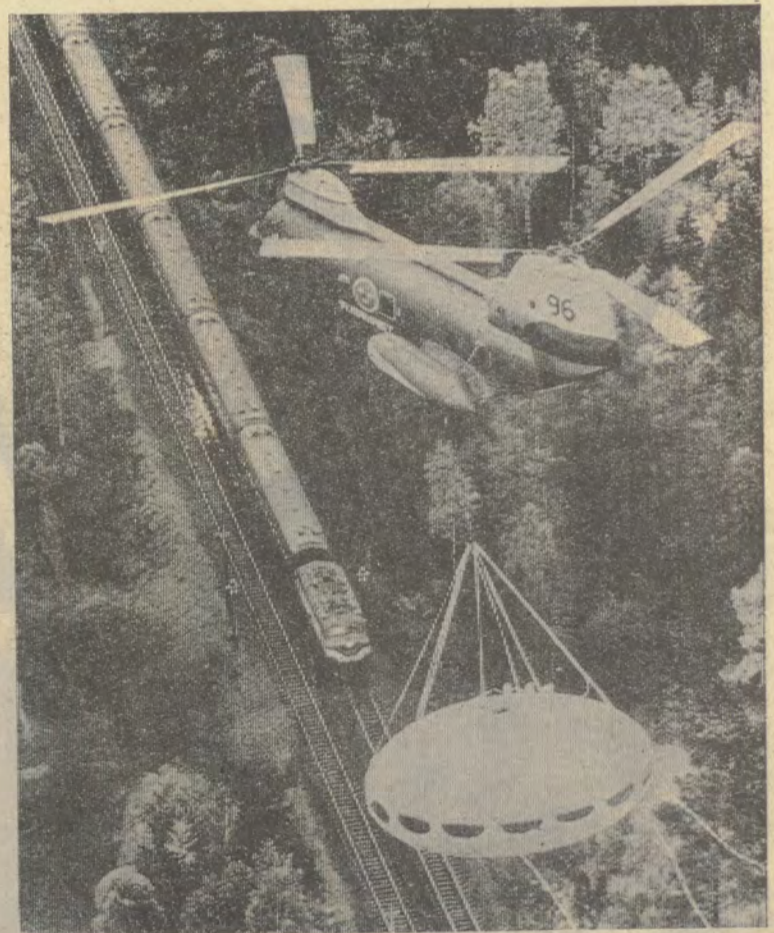
Geen vliegende schotels maar een bungalow in de vorm van een afgeplat ei die per helikopter in Zweden ter plaats van bestemming werd gebracht
