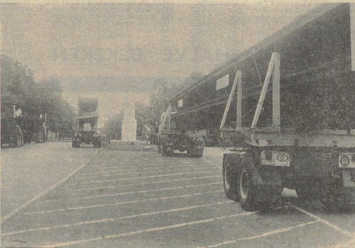
Voor de bouw van een tijdelijke verkeersbrug aan het Montgomeryplein te Brussel arriveerden vrijdagmiddag de eerste zetsstukken. Eenveerig uren later was de 450 m. lange brug met 108 stalen elementen, berekend voor het dragen van een 16 tonner, kant en klaar, ruim 40 uren voor de officieel voorziene tijd en nog 2 uren vóór de timing door de ondernemer. Een unieke prestatie van ijverige en bekwame vlaamse bruggenbouwers, die daarmee het europes rekord braken. De Brusselselaars vergaten er alle commentaar bij...
