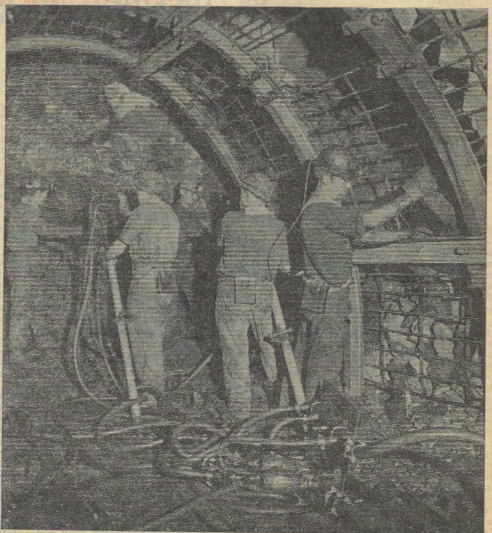
Op de foto bovenaan zien we een hakschaaf aan het werk onder een metalen schoring. Hierboven een beeld in een galerij die geschoord is met betonstukken. Is men in Limburg hier en daar aan moderne middelen toe, dan is dit op sociaal gebied — zoals blijkt uit ons verhaal — niet steeds het geval.
